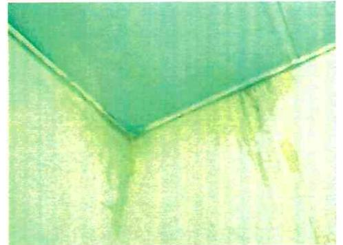
Vista de muros interior húmedos a consecuencia de filtraciones de agua, debilitando la estructura.
