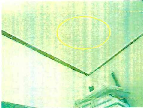
Vista del cielo raso en mal estado, presencia de humedad y desprendimiento de del cielo raso y del tapajuntas de madera por la humedad Presentada.
