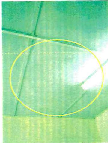
Vista del cielo raso en mal estado, presencia de humedad y desprendimiento de del cielo raso y del tapajuntas de madera por la humedad presentada.
